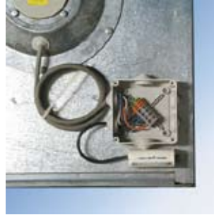
podłączenie silników do listw zaciskowych ułatwiające instalację
