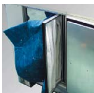
łatwo wymienne filtry klasy A dla EN 1886
